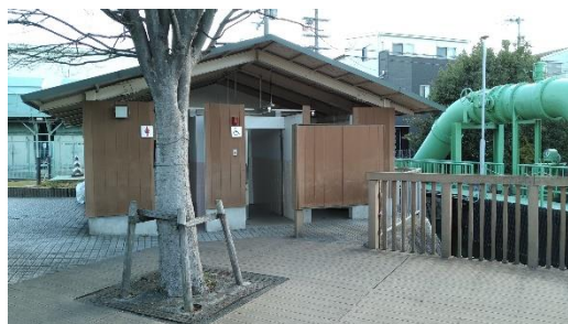
清水池 雨水排水ポンプ
