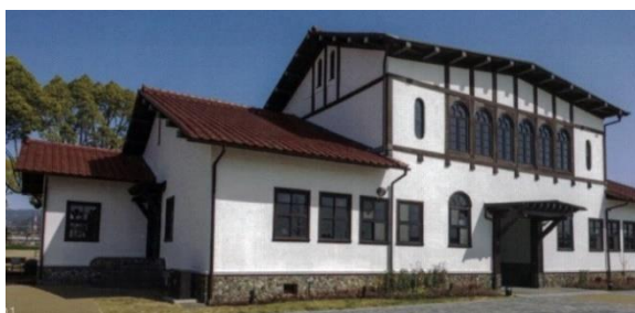
南西側から見た 本館
