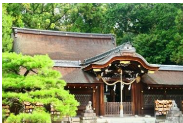
檜皮葺の屋根が素敵な本殿 手前の唐破風造の拝所
