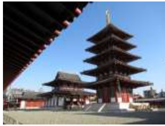
奥から講堂・金堂・五重塔
