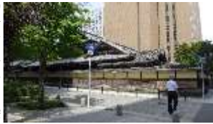
重要文化財の愛珠幼稚園園舎
