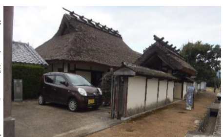
武家屋敷安間家資料館
