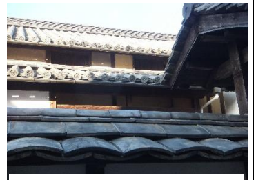
家プロジェクト第1号「角屋」の重厚な屋根
