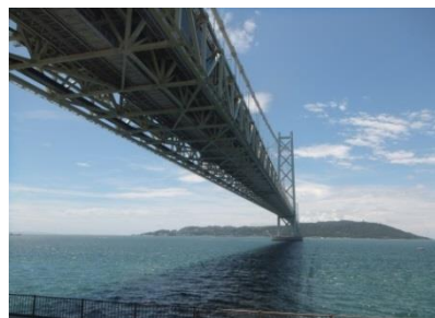
世界一のつり橋明石大橋
