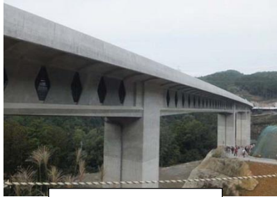
高速道路芥川橋
