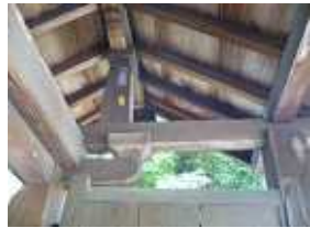
神門は、薬医門造りの門で、本柱（前方）と控え柱（後方）の 4 本の柱の上に冠木や梁などを組み合わせたその上に切妻屋根
