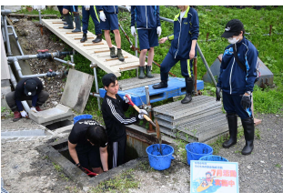
汚水桧の浚渫作業
